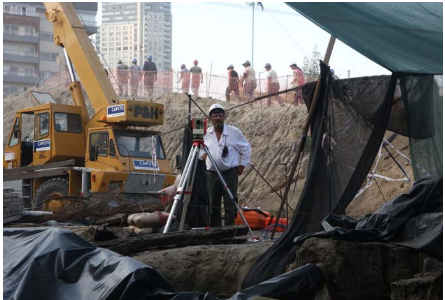
Relevamiento tridimensional con el uso de estación total. Fotos: Silvina Arrastía.
